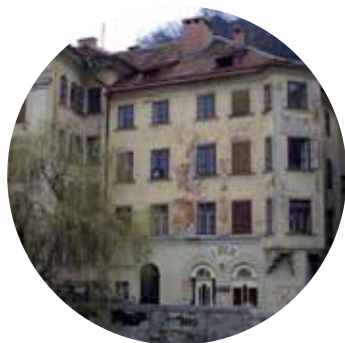
Primjer objekta prije obnavljanja
