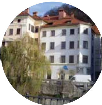
Primjer objekta nakon obnavljanja Izvor materijala: GIVO d.o.o., Ljubljana
